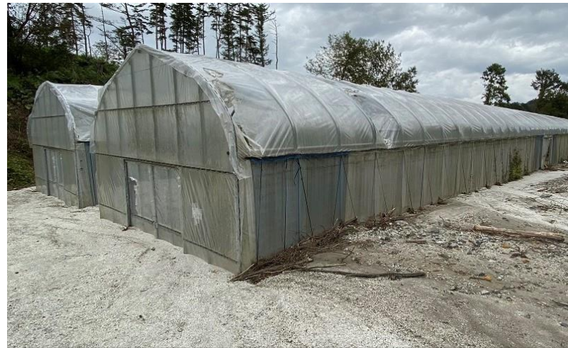
大量の土砂で1メートル程埋まったトマトハウス。
