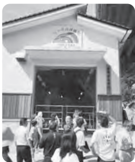
めぐみ発電所建屋
